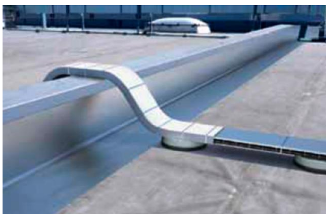
Slika: Primer pravilnega polaganja kablov preko požarnega zidu na strehi
